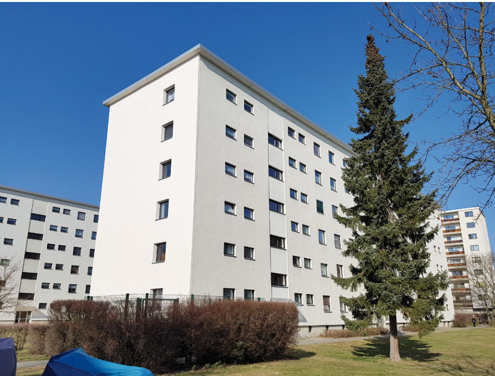
Erfolgreiche Fassadenarbeiten an unserer Wohnanlage Klamannstraße in Reinickendorf
